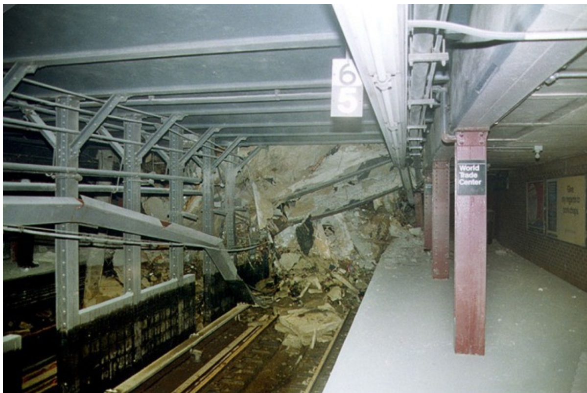
Частичное обрушение потолка на станции метро под ВТЦ.
