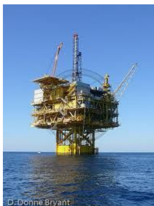
Буровая платформа над скважиной MC243
